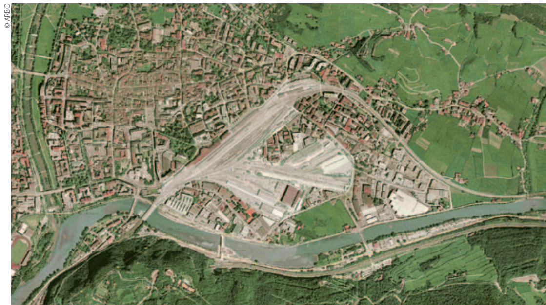
Luftbild des Istzustandes, Altstadt – Bahnhofsareal
