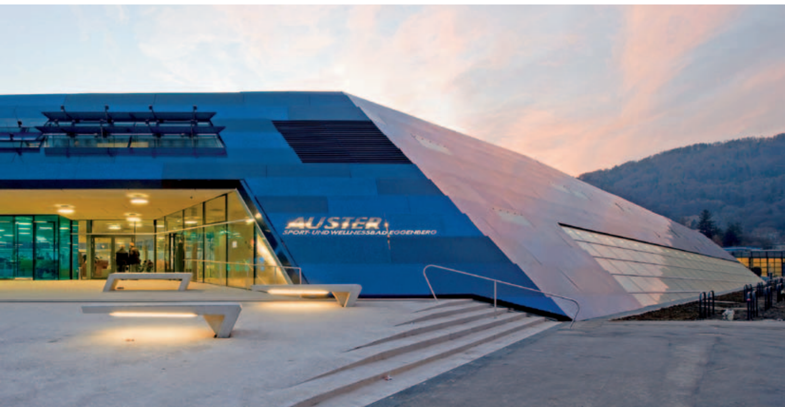
Haupteingangsbereich mit Fassade Georgigasse
