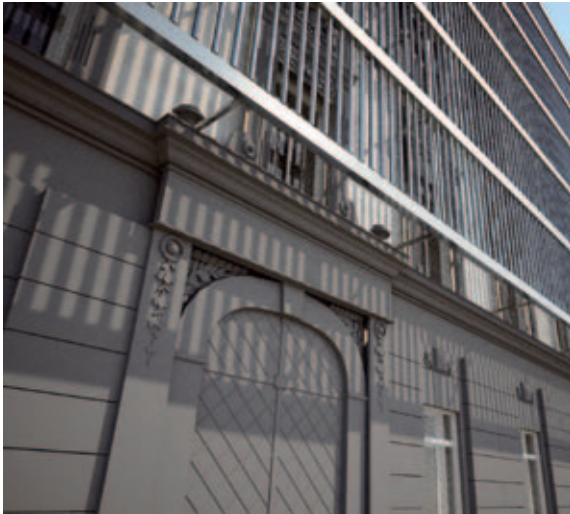
Abb.4: „Case-Story“ Radetzkystraße: Ein Detail der ausgewählten Lösung mit Vakuumkollektoren, Institut für Gebäudelehre / TU Graz
