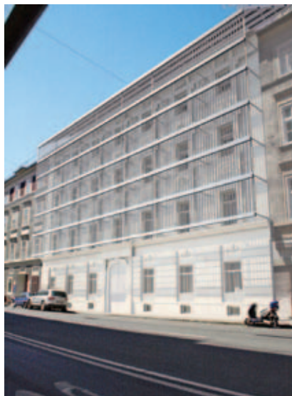
Abb.5: „Case-Story“ Radetzkystraße: Aufnahme des Ist-Zustands der straßenseitigen Fassade und Fotomontage einer Gestaltungsvariante mit Vakuum- Röhrenkollektoren, Institut für Gebäudelehre / TU Graz
