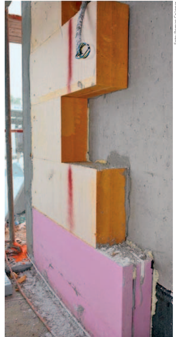
Abb. 6: Ausführung des Resol-WDVS. Anschluss an XPS-Perimeterdämmung.
