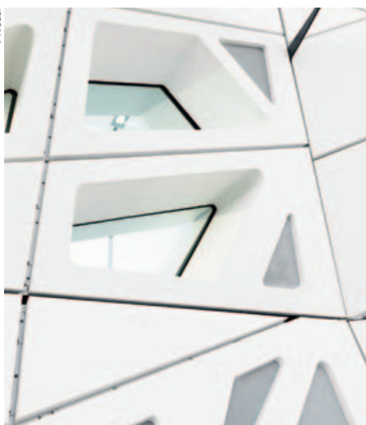
„Rieder Monolithic Cast“: Dreidimensionale Fassadenelemente, in einem Stück gegossen.
