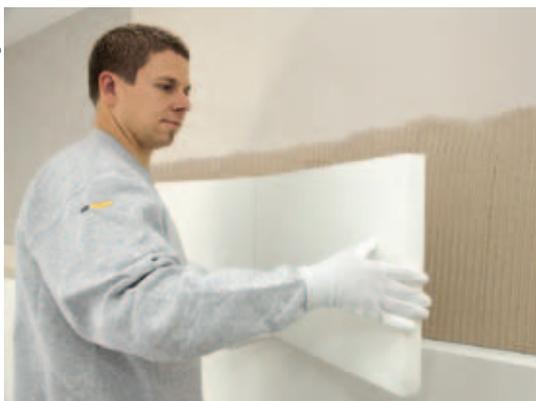
Die neue Sto-Aeverso Innendämmplatte mit einem Lambda-Wert von  $0,016 \text{ W}/(\text{m}^2\text{K})$ .
