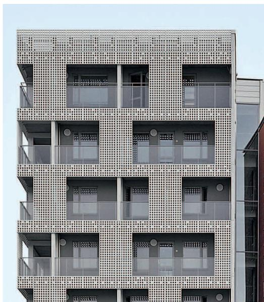
dreidimensionale Fassadenplatten. Die perforierten Fassadenelemente sind 7 cm dick und auf allen Seiten schalungsglatt. Die vorgelagerte Lochfassade dient als raffinierter Sicht- und Sonnenschutz ohne dabei auf die Lichtverhältnisse der Räume einzugreifen.
