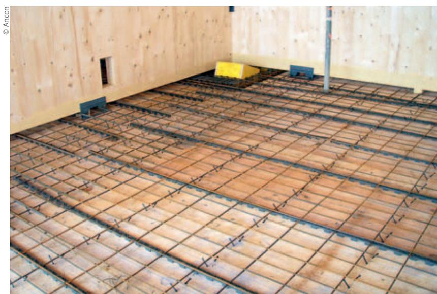
Beim Wohnbau Wagramer Straße wurden 2.400 m<sup>3</sup> Brettsperrholz verarbeitet. Verbundschrauben vom System SFS VB ermöglichten die Berechnung der Holzverbunddecken als Mehrfeldträger.
