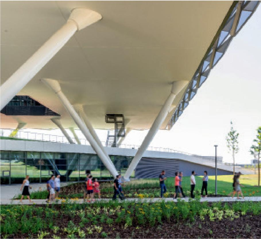
Die drei Obergeschoße ruhen auf 67 V-förmig angeordneten, mit Beton verfüllten Stahlrohrmantelstützen.
