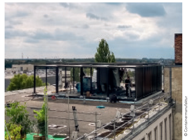
Highcubes zusammengefasst zu einem Penthouse auf einem 100-jährigen Fabrikgebäude in Berlin. Bauzeit: 6 Monate
