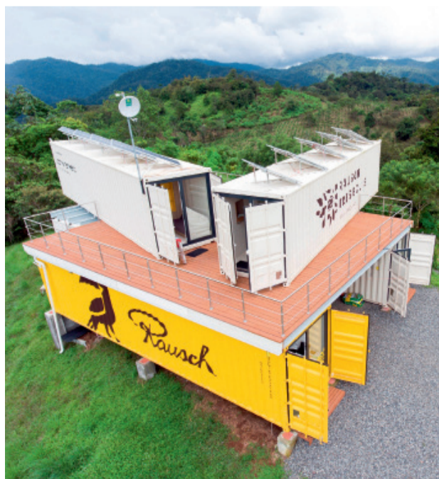
Autarke Basisstation in Costa Rica mit Übernachtungsmöglichkeit, kleinem Labor und Büro (Rausch Schokolade und Containerwerk)
