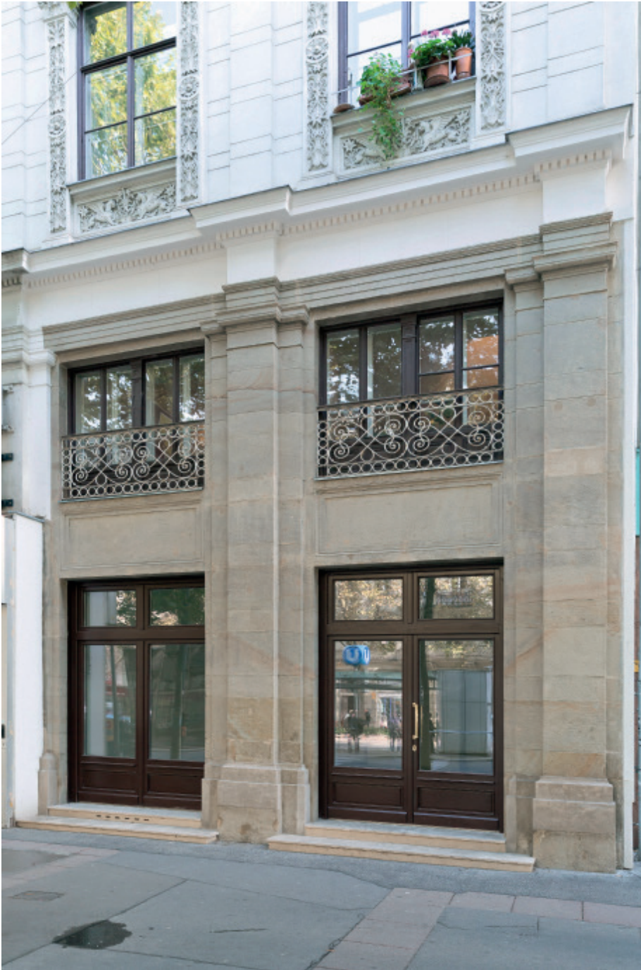
Sanierte Fassade in der Praterstraße in Wien mit Ergänzungen aus Originalmaterial
