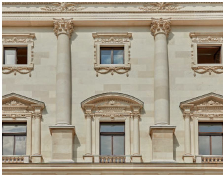
Detailansicht des westlichen Fassadenabschnittes nach der Sanierung
