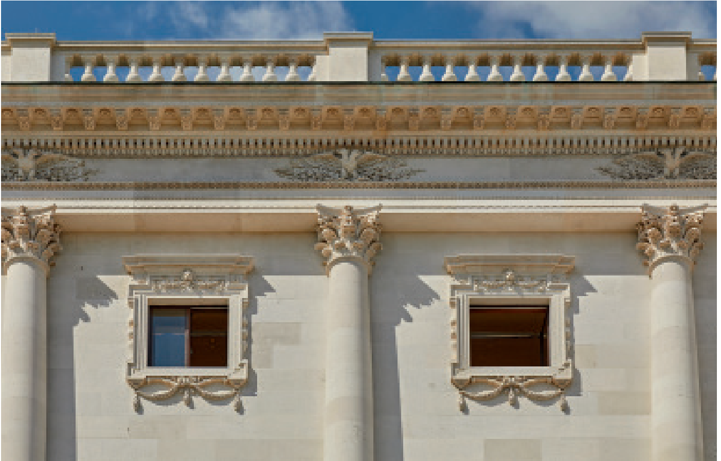
Ein weit auskragendes Hauptgesims mit Architrav und Doppeladler-Fries bildet den horizontalen Abschluss.
