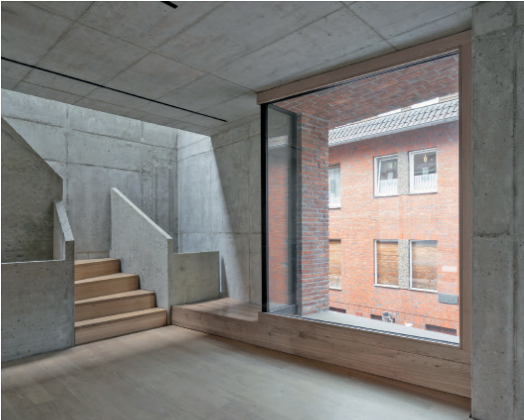
Bewusst rauer Charakter: außen Ziegel, innen Sichtbeton
