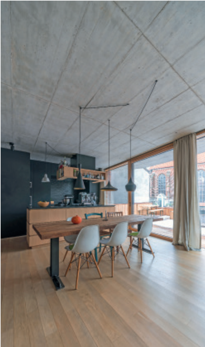
Der Bodenbelag besteht aus massiven, geölten Eichendielen auf Lagerhölzern.
