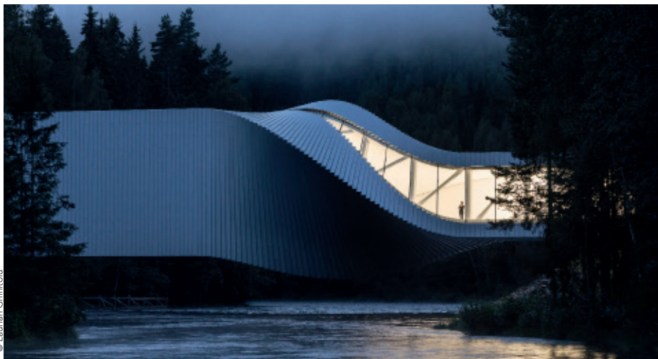
Die Glasfassade von „The Twist“ in Jevnaker bei Oslo wurde als Structural Glazing-Fassade realisiert.
