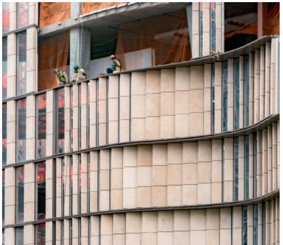
Präzise und schnell montiert: Sämtliche Ankerlöcher waren ab Werk kalibriert.
