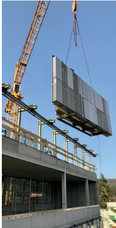
Montage der Fassadenelemente
