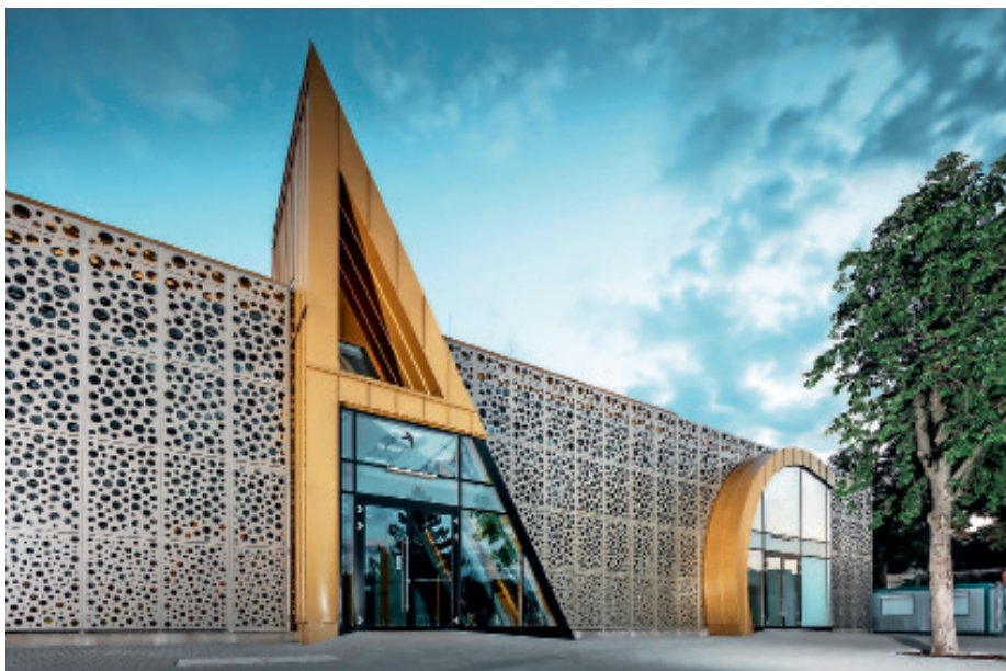
Die Markthalle im ungarischen Nagykovács erstrahlt in metallischen Gold-Bronze-Tönen, ausgeführt als Prefa-Aluminiumfassade.
