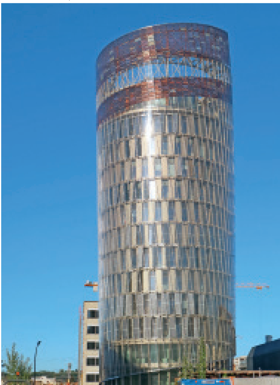
Der Mantel des Science Towers Graz besteht aus transparenten Energie-Gläsern, die Licht in elektrische Energie umwandeln.
