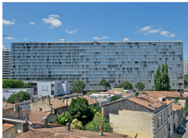
Drei Gebäude mit Sozialwohnungen in Bordeaux aus den 60er-Jahren wurden vom Pariser Architekturbüro Lacaton & Vassal renoviert bzw. upgecycelt.
