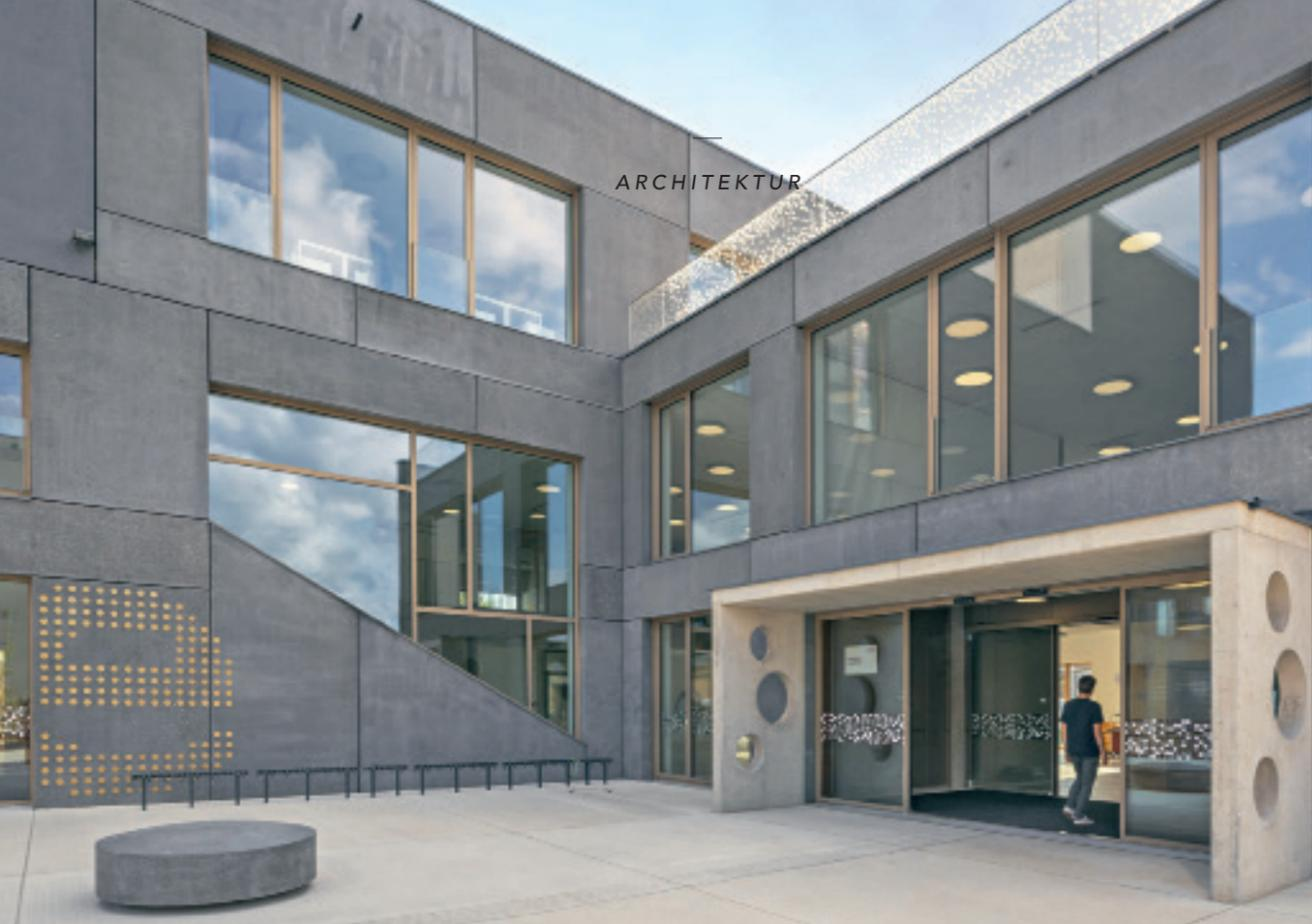
Das Fenstersystem besteht aus selbsttragenden, bis zu sechs Meter langen Stahlprofilen.
