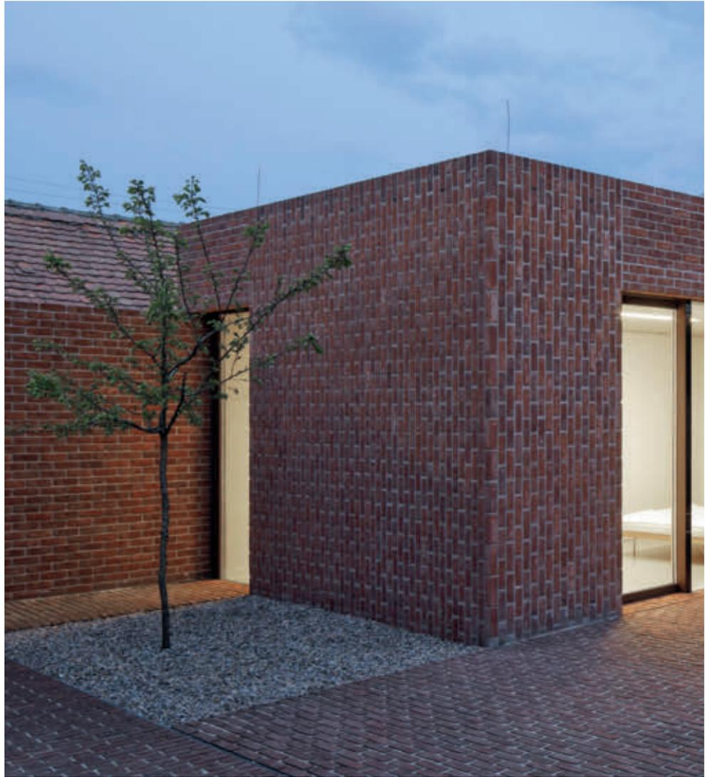
Wechselweise horizontal und vertikal geschichtete Backsteine sorgen für Abwechslung im Fassadenbild. |
